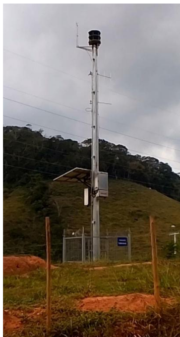
Visita de campo - Instalação da Sirene TW4 . Empreendimento, Cliente. Município (UF), 19/05/2026
