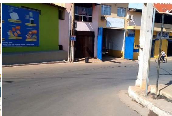
Visita de campo – Placa sinalizadora da Rota de Fuga 06-C . Estação de Bombeamento 2 (EB2), Anglo American. Santo Antônio do Grama (MG), 19/05/2026
