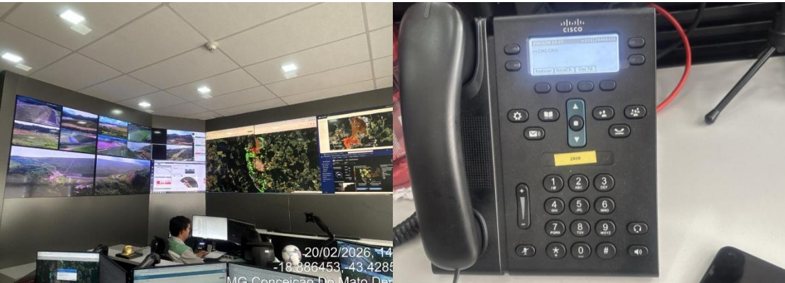
Centro de Monitoramento Geotécnico. EB2, Anglo American. Conceição do Mato Dentro (MG), Maio/2026 Centro de Monitoramento Geotécnico. EB2, Anglo American. Conceição do Mato Dentro (MG), Maio/2026
