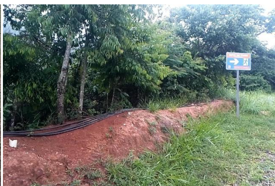
Visita de campo – Placa sinalizadora da Rota de Fuga 13-B . Estação de Bombeamento 2 (EB2), Anglo American. Santo Antônio do Grama (MG), Maio/2026
