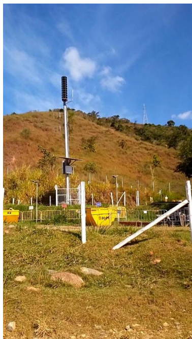
Visita de campo - Instalação da Sirene TW3 . Empreendimento, Cliente. Município (UF), 20/05/2026
