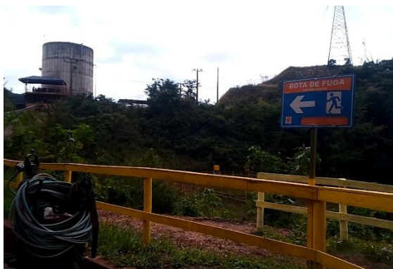
Visita de campo – Placa sinalizadora da Rota de Fuga 12-A . Estação de Bombeamento 2 (EB2), Anglo American. Santo Antônio do Grama (MG), 20/05/2026
