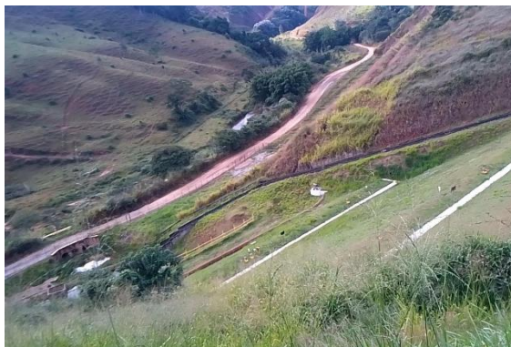
Visita de campo – Placa sinalizadora da Rota de Fuga 09-E . Estação de Bombeamento 2 (EB2), Anglo American. Santo Antônio do Grama (MG), 21/05/2026
