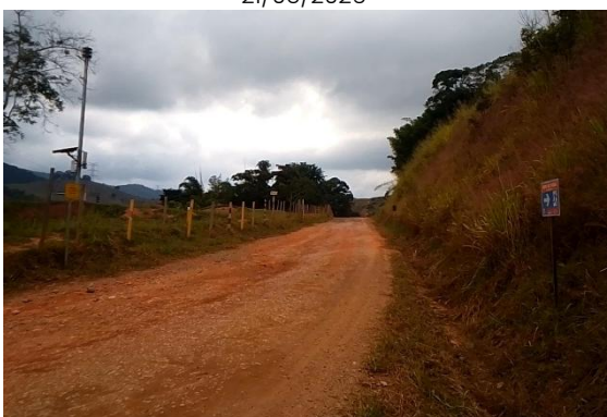
Visita de campo - Placa sinalizadora da Rota de Fuga 02-B . Estação de Bombeamento 2 (EB2), Anglo American. Santo Antônio do Grama (MG), 20/05/2026
