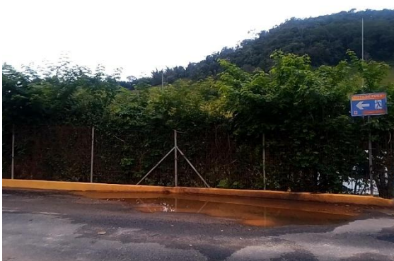
Visita de campo - Placa sinalizadora da Rota de Fuga 01 . Estação de Bombeamento 2 (EB2), Anglo American. Santo Antônio do Grama (MG), 21/05/2026
