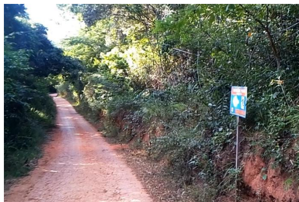
Visita de campo – Placa sinalizadora da Rota de Fuga RF-17-B . Barragem de Rejeitos, Anglo American. Conceição do Mato Dentro (MG), Maio/2026
