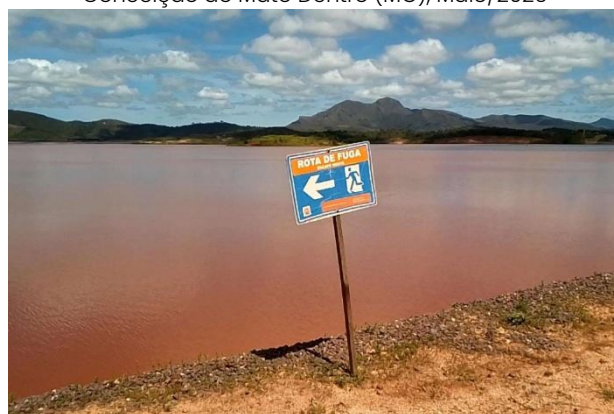
Visita de campo – Placa sinalizadora da Rota de Fuga RF-PE-04-BRJ-OD-A . Barragem de Rejeitos, Anglo American. Conceição do Mato Dentro (MG), Maio/2026
