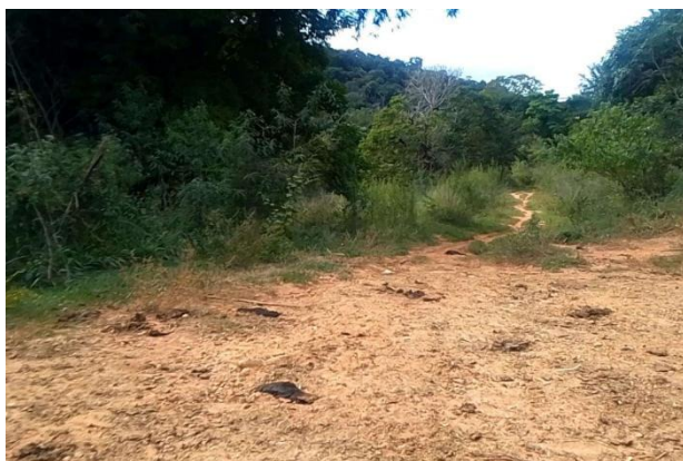
Visita de campo – Sem autorização de instalação de placas – Rota de Fuga RF-15-D. Barragem de Rejeitos, Anglo American. Conceição do Mato Dentro (MG), Maio/2026
