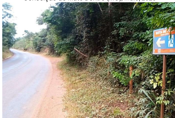
Visita de campo – Placa sinalizadora da Rota de Fuga RF-RF-21 . Barragem de Rejeitos, Anglo American. Conceição do Mato Dentro (MG), Maio/2026
