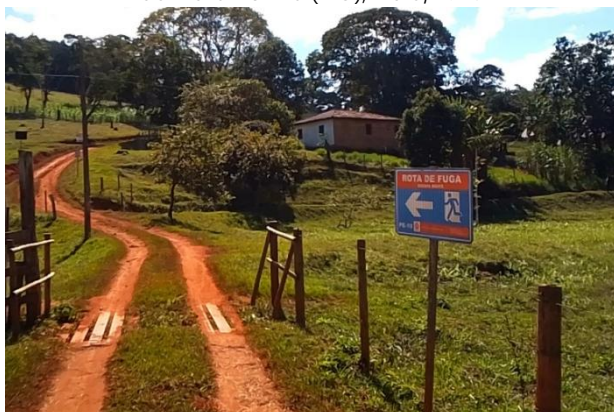
Visita de campo – Placa sinalizadora da Rota de Fuga RF-10-B . Barragem de Rejeitos, Anglo American. Conceição do Mato Dentro (MG), Maio/2026
