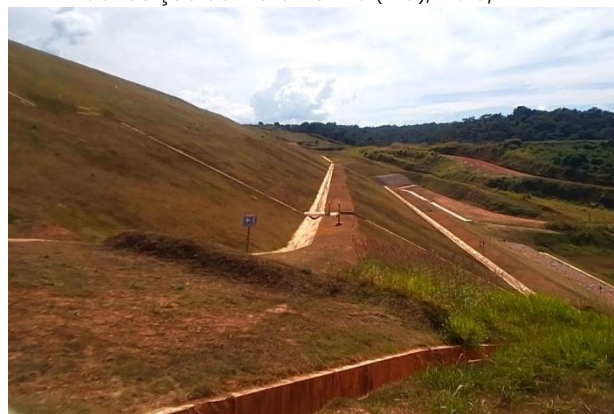
Visita de campo – Placa sinalizadora da Rota de Fuga RF-PE-03-BRJ-OD-E . Barragem de Rejeitos, Anglo American. Conceição do Mato Dentro (MG), Maio/2026
