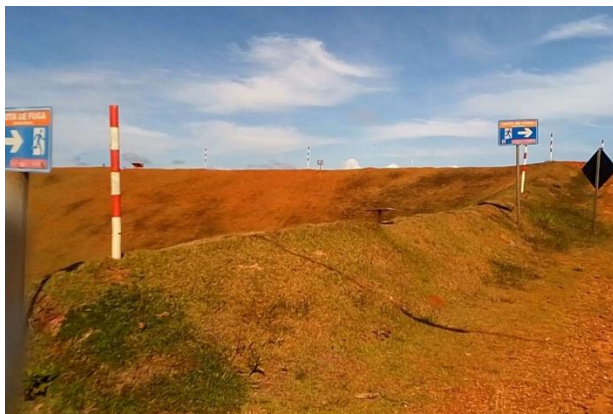
Visita de campo – Placa sinalizadora da Rota de Fuga RF-PE-02-BRJ-OE-B . Barragem de Rejeitos, Anglo American. Conceição do Mato Dentro (MG), Maio/2026
