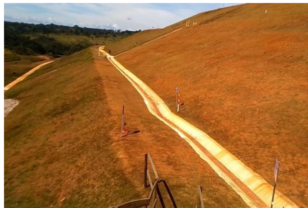
Visita de campo – Placa sinalizadora da Rota de Fuga RF-PE-02-BRJ-OE-C . Barragem de Rejeitos, Anglo American. Conceição do Mato Dentro (MG), Maio/2026
