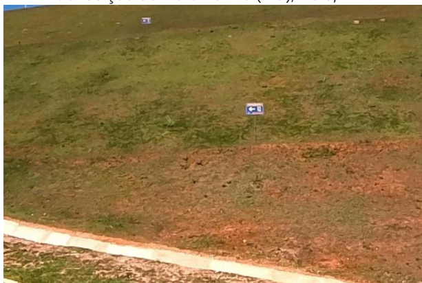
Visita de campo – Placa sinalizadora da Rota de Fuga RF-PE-03-BRJ-OD-B . Barragem de Rejeitos, Anglo American. Conceição do Mato Dentro (MG), Maio/2026
