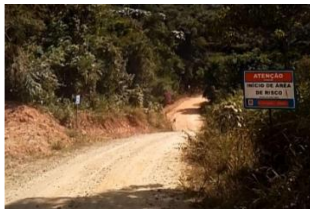
Visita de campo – Placa sinalizadora da Rota de Fuga RF-RF-22 . Barragem de Rejeitos, Anglo American. Conceição do Mato Dentro (MG), Maio/2026
