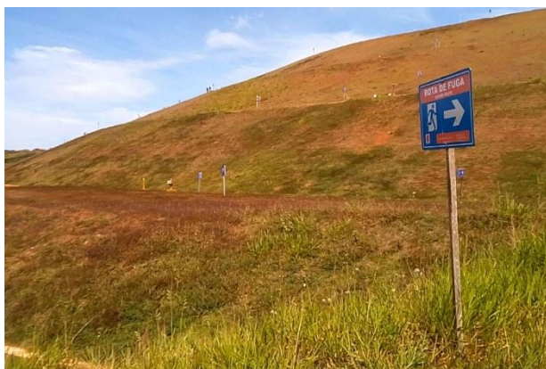
Visita de campo – Placa sinalizadora da Rota de Fuga RF-PE-02-BRJ-OE-H . Barragem de Rejeitos, Anglo American. Conceição do Mato Dentro (MG), Maio/2026
