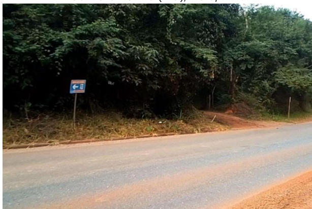
Visita de campo – Placa sinalizadora da Rota de Fuga RF-PF-19-A . Barragem de Rejeitos, Anglo American. Conceição do Mato Dentro (MG), Maio/2026
