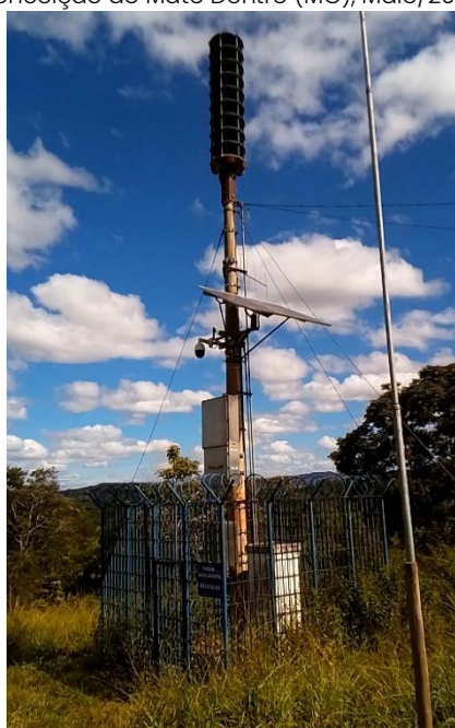
Visita de campo – Instalação da Sirene Água Quente . Barragem de Rejeitos, Anglo American. Conceição do Mato Dentro (MG), Maio/2026
