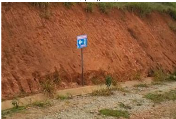
Visita de campo – Placa sinalizadora da Rota de Fuga RF-11-A . Barragem de Rejeitos, Anglo American. Conceição do Mato Dentro (MG), Maio/2026
