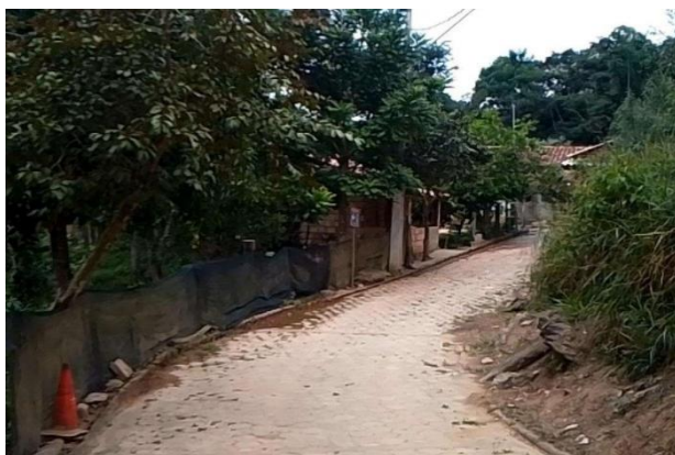
Visita de campo – Placa sinalizadora da Rota de Fuga RF-08-E . Barragem de Rejeitos, Anglo American. Conceição do Mato Dentro (MG), Maio/2026
