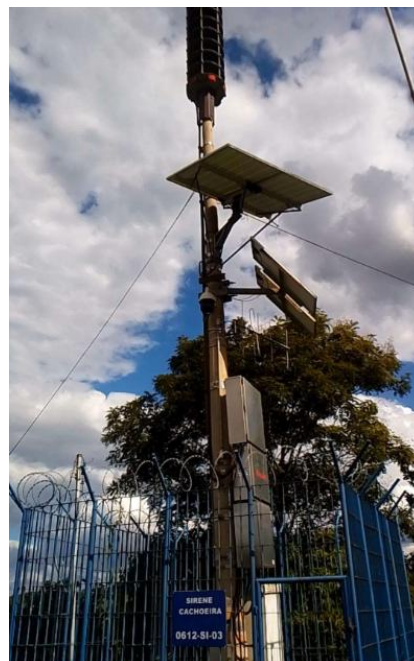
Visita de campo – Instalação da Sirene Cachoeira . Barragem de Rejeitos, Anglo American. Conceição do Mato Dentro (MG), Maio/2026
