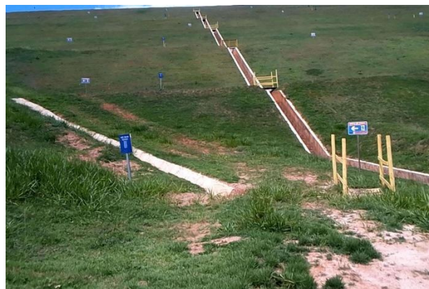
Visita de campo – Placa sinalizadora da Rota de Fuga RF-PE-01-BRJ-OE-B . Barragem de Rejeitos, Anglo American. Conceição do Mato Dentro (MG), Maio/2026
