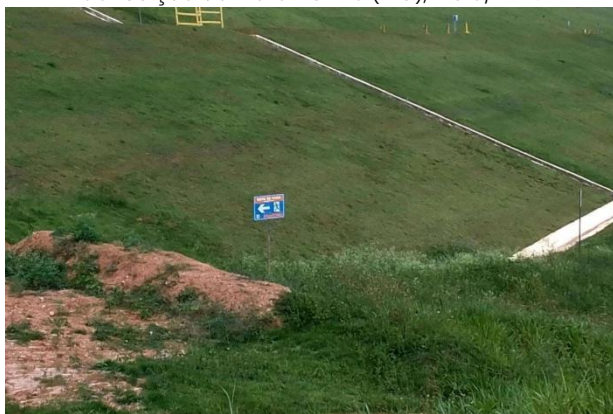
Visita de campo – Placa sinalizadora da Rota de Fuga RF-PE-03-BRJ-OD-D . Barragem de Rejeitos, Anglo American. Conceição do Mato Dentro (MG), Maio/2026
