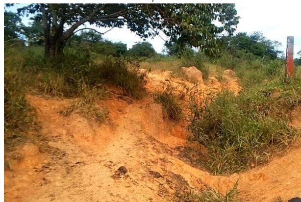
Visita de campo – Sem autorização de instalação de placas – Rota de Fuga RF-15-C . Barragem de Rejeitos, Anglo American. Conceição do Mato Dentro (MG), Maio/2026
