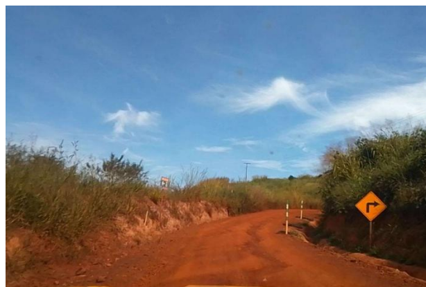
Visita de campo – Placa sinalizadora da Rota de Fuga RF-PE-04-BRJ-OD-E . Barragem de Rejeitos, Anglo American. Conceição do Mato Dentro (MG), Maio/2026
