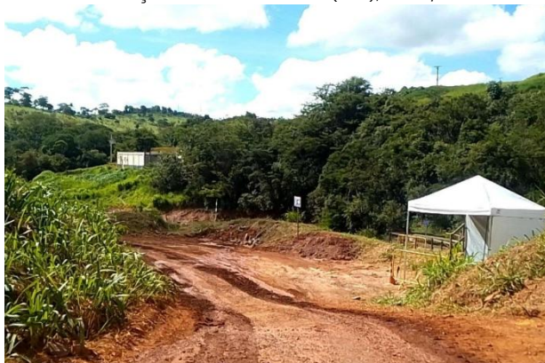
Visita de campo – Placa sinalizadora da Rota de Fuga RF-PE-01-BRJ-OE-E . Barragem de Rejeitos, Anglo American. Conceição do Mato Dentro (MG), Maio/2026
