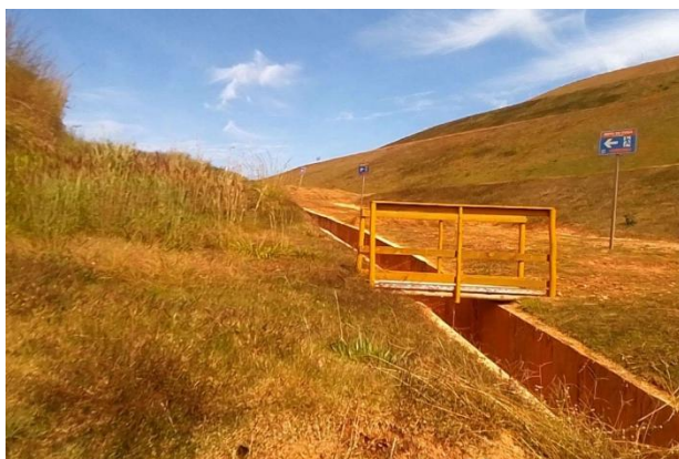
Visita de campo – Placa sinalizadora da Rota de Fuga RF-PE-04-BRJ-OD-D . Barragem de Rejeitos, Anglo American. Conceição do Mato Dentro (MG), Maio/2026
