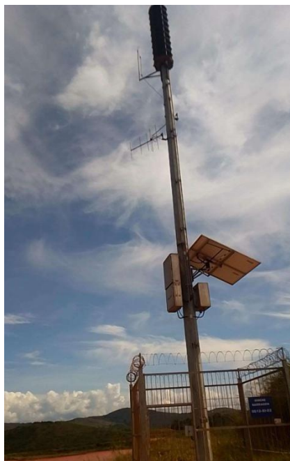
Visita de campo – Instalação da Sirene Barragem de Rejeitos . Barragem de Rejeitos, Anglo American. Conceição do Mato Dentro (MG), Maio/2026
