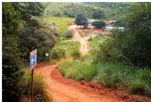
Visita de campo – Placa sinalizadora da Rota de Fuga RF-18-D . Barragem de Rejeitos, Anglo American. Conceição do Mato Dentro (MG), Maio/2026
