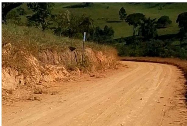
Visita de campo – Placa sinalizadora da Rota de Fuga RF-07-E . Barragem de Rejeitos, Anglo American. Conceição do Mato Dentro (MG), Maio/2026
