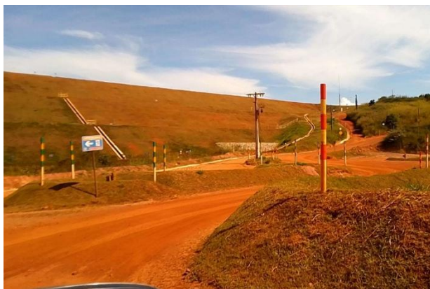
Visita de campo – Placa sinalizadora da Rota de Fuga RF-PE-01-BRJ-OE-A . Barragem de Rejeitos, Anglo American. Conceição do Mato Dentro (MG), Maio/2026
