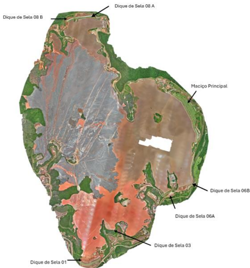
Figura 2: Localização dos Diques de Sela. Fonte: Relatório de Inspeção de Segurança Regular (WSP, 2026).
