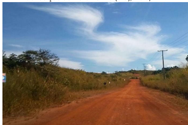
Visita de campo – Placa sinalizadora da Rota de Fuga RF-PE-01-BRJ-OE-D . Barragem de Rejeitos, Anglo American. Conceição do Mato Dentro (MG), Maio/2026
