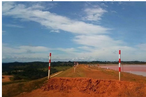
Visita de campo – Placa sinalizadora da Rota de Fuga RF-PE-02-BRJ-OE-A . Barragem de Rejeitos, Anglo American. Conceição do Mato Dentro (MG), Maio/2026
