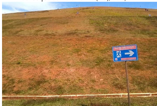
Visita de campo – Placa sinalizadora da Rota de Fuga RF-PE-02-BRJ-OE-G . Barragem de Rejeitos, Anglo American. Conceição do Mato Dentro (MG), Maio/2026
