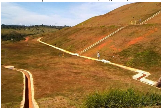
Visita de campo – Placa sinalizadora da Rota de Fuga RF-PE-02-BRJ-OE-D . Barragem de Rejeitos, Anglo American. Conceição do Mato Dentro (MG), Maio/2026
