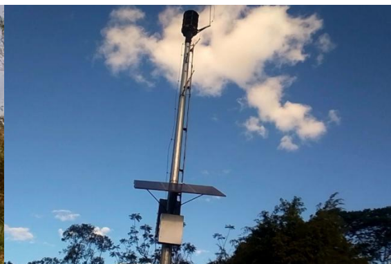
Visita de campo - Instalação da Sirene TW2 (Dique 3) . Dique de Contenção de Sedimentos 5, Anglo American. Conceição do Mato Dentro (MG), Maio/2026.
