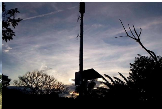
Visita de campo - Instalação da Sirene TW6 (Dique 3) . Dique de Contenção de Sedimentos 5, Anglo American. Conceição do Mato Dentro (MG), Maio/2026.
