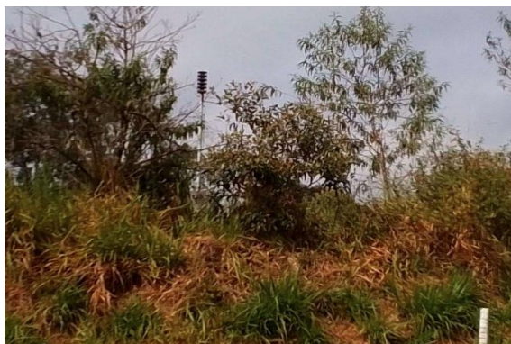
Visita de campo - Instalação da Sirene TW1 (Dique 4 e 5) . Dique de Contenção de Sedimentos 5, Anglo American. Conceição do Mato Dentro (MG), Maio/2026.
