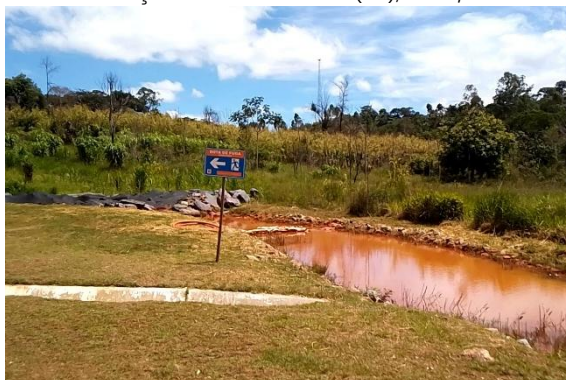
Visita de campo – Placa sinalizadora da Rota de Fuga RF-PE-16-D5-OD-B . Dique 5, Anglo American. Conceição do Mato Dentro (UF), Maio/2026
