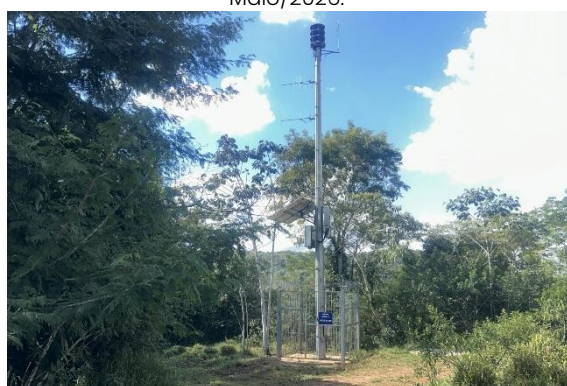
Visita de campo - Instalação da Sirene TW3 (Dique 3) . Dique de Contenção de Sedimentos 5, Anglo American. Conceição do Mato Dentro (MG), Maio/2026.
