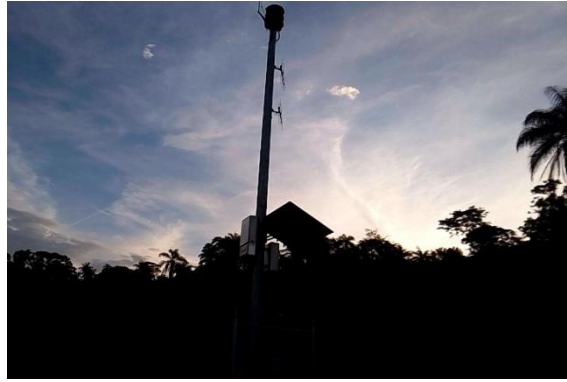
Visita de campo – Instalação da Sirene TW7 (Dique 3) . Dique de Contenção de Sedimentos 5, Anglo American. Conceição do Mato Dentro (MG), Maio/2026.
