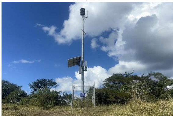
Visita de campo - Instalação da Sirene TW5 (Dique 3) . Dique de Contenção de Sedimentos 5, Anglo American. Conceição do Mato Dentro (MG), Maio/2026.
