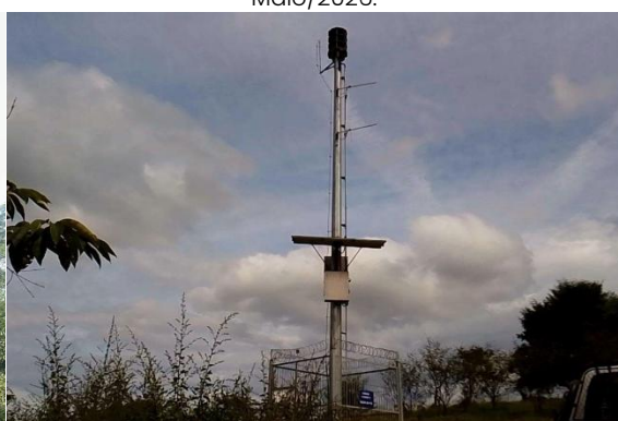
Visita de campo - Instalação da Sirene TW4 (Dique 3) . Dique de Contenção de Sedimentos 5, Anglo American. Conceição do Mato Dentro (MG), Maio/2026.
