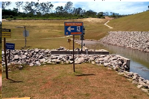
Visita de campo – Placa sinalizadora da Rota de Fuga RF-PE-16-D5-OD-C . Dique 5, Anglo American. Conceição do Mato Dentro (UF), Maio/2026
